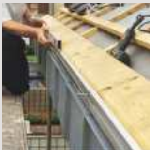
Az aljzat egyenességének, vízszinteségének és függőlegességének felülvizsgálata
