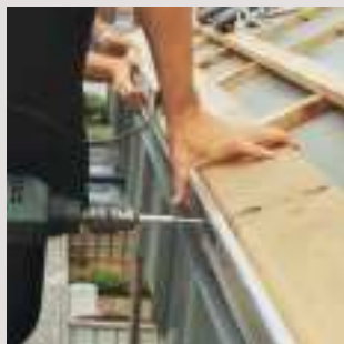
A RHEINZINK®-DH szerelősínek rögzítése az eresz vonala alatt
