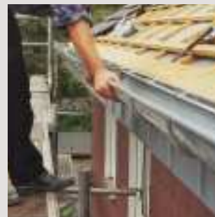
A RHEINZINK®-ereszcsatorna behelyezése, külső peremének a csatornatartó végére pattintásával
