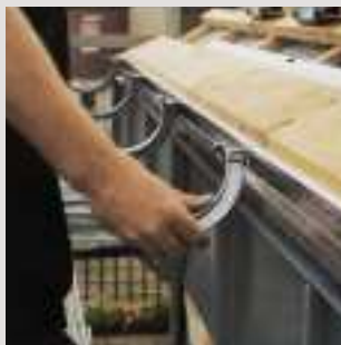
A csatornatartókat a szarufák közelében behelyezik a szerelősínekbe
